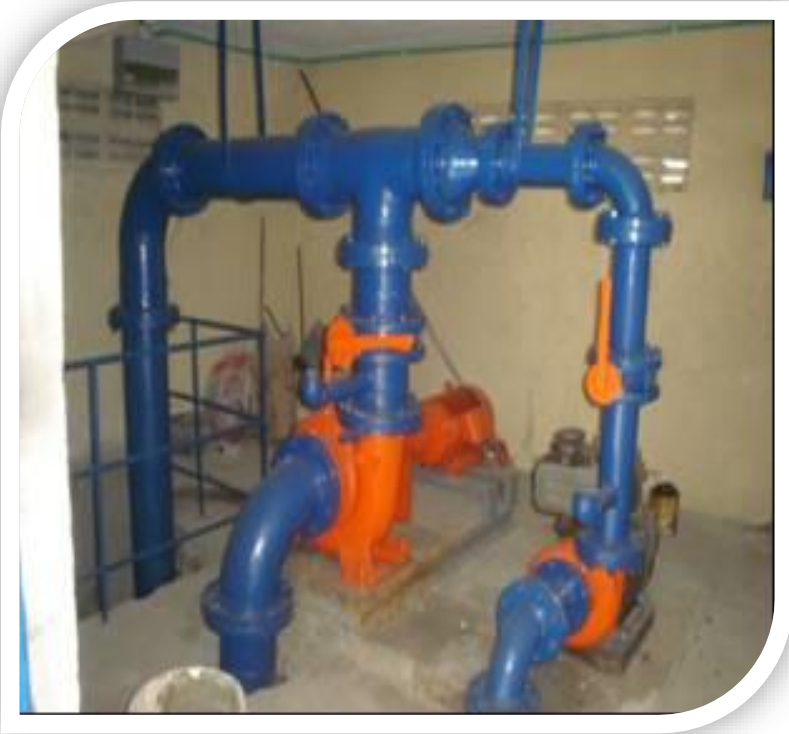
Subestación Juan XXIII
