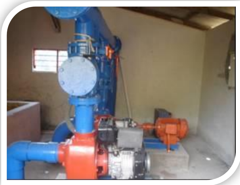
Subestación XX Julio con SENA
