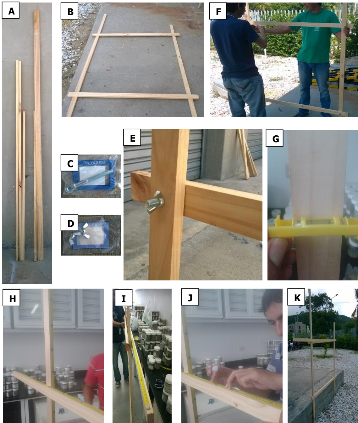
Figura 3.1 Metodología para la construcción de perfilador. A: Cinco piezas de madera. B: forma de armado del perfilador. C: Tornillos. D: Tuercas de mariposa. E-F: Unión de piezas horizontales y verticales. G: colocado de nivel. H-I-J: colocado de las cintas métricas en la barra niveladora y bastón delantero. K: perfilador finalizado.
