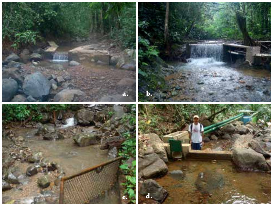
Figura 7. Tipos de tomas de agua. a) Represa baja (quebrada La Carolina, Capurganá, municipio de Acandí, Chocó); b) represa alta (quebrada Capurganá, Capurganá, municipio de Acandí, Chocó); c) toma lateral (quebrada Ilú, Parque Nacional Natural Gorgona); d) represa baja utilizada para generación hidroeléctrica (quebrada Pizarro, Parque Nacional Natural Gorgona). Nótese que la represa alta bloquea la migración de fauna diádroma río arriba, pero el sistema de toma mediante rejilla (a-c) o tubo (d) en los cuatro ejemplos captura un número significativo de larvas derivando aguas abajo. Fotos: J. F. Blanco.
