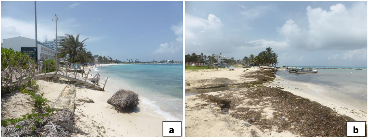
Figura 5.1 Playa Sprat Bight a) Obras de protección y restauración de dunas, b) sector de la cooperativa de pescadores.
