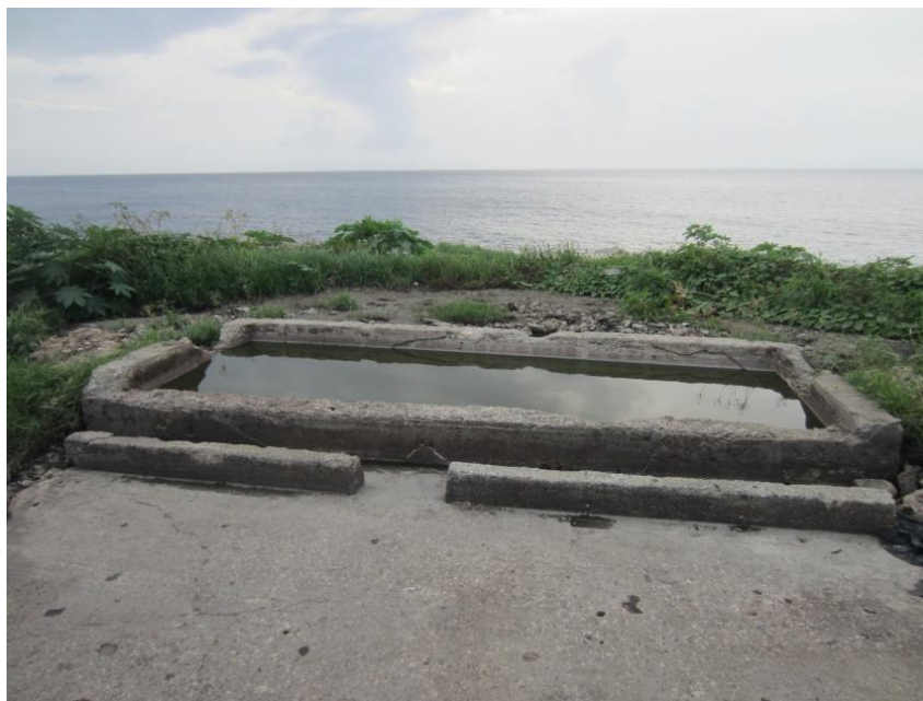
Foto 11-7. Punto de descarga de lodos en el Km 3, sector Morris Landing.
