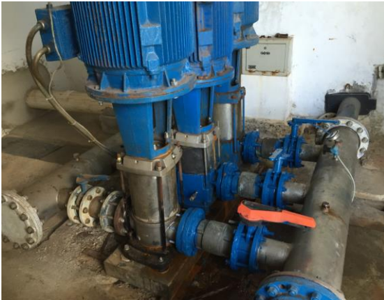
Foto 8-4 Sitios para medición de caudal y presión en el sistema de bombeo de Lox Bight
