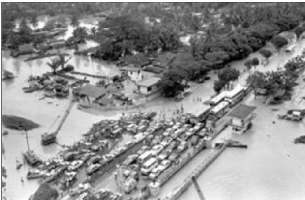
Foto 12-3 Aspecto general de inundación Bradell Road, Singapur. Diciembre de 1978
