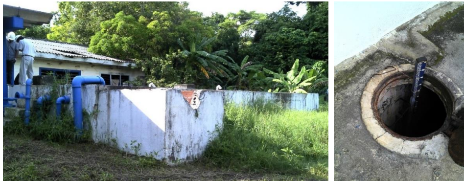
Foto 7-3 Panorámica tanque de recepción agua, regleta para medición de nivel
