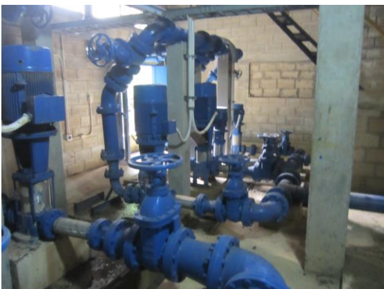
Foto 8-5 Sitios para medición de caudal y presión en el sistema de bombeo de Lox Bight
