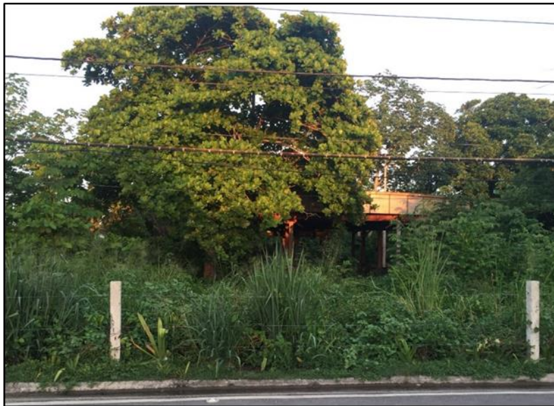
Foto 9-41 Estado actual PTAR KROFTA
