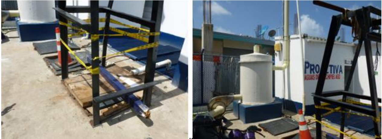
Foto 9-12 Tapas superiores del pozo húmedo. Estación de bombeo 1
