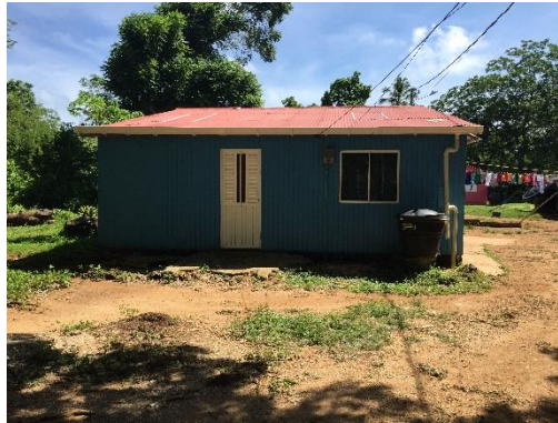
Foto 8-2 Sistema típico de recolección de agua lluvias
