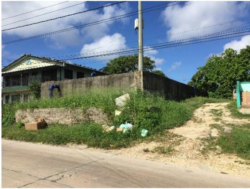
Foto 8-8 Fotografías tanques de La Loma, San Luis y Cove
