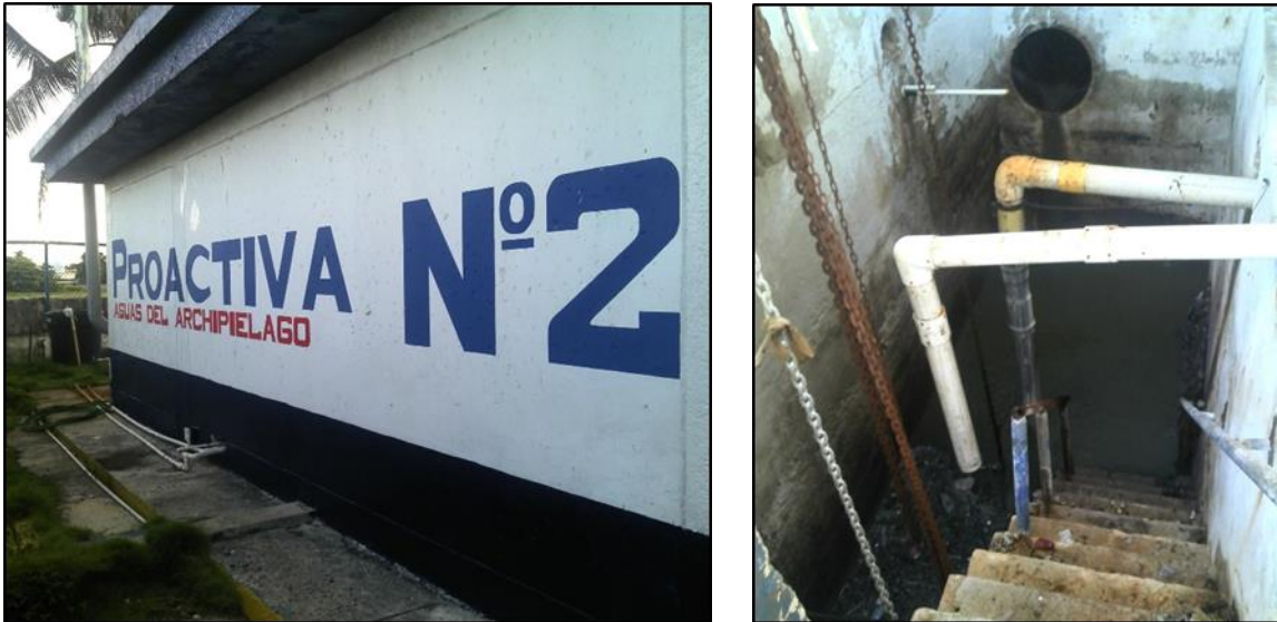
Foto 9-4 Estación de Bombeo No 2
