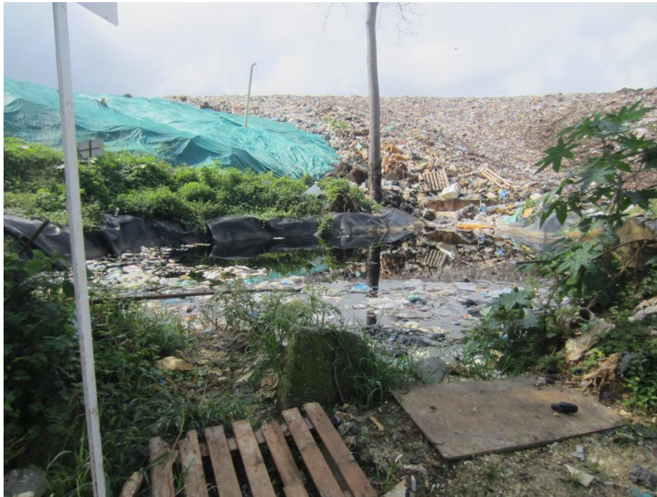
Foto 11-14. Piscina de lixiviados contigua al Área 4.
