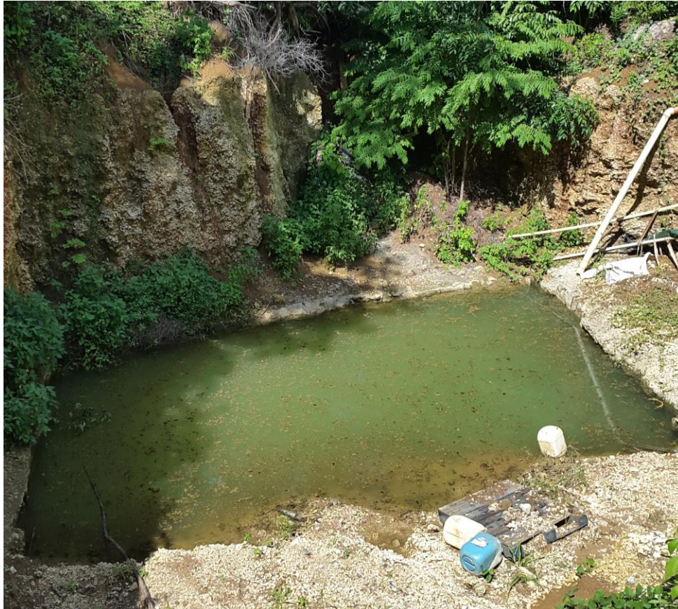
Figura 9-47 Excavación Estación de Bombeo No 4
