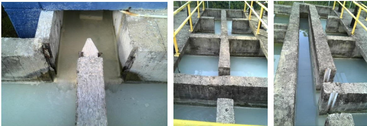
Foto 7-9 Ingreso a las unidades de floculación, cámara de floculadores, salida y canal agua floculada.
