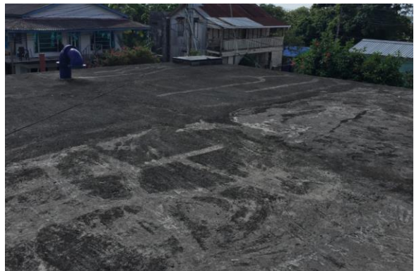
Tanque La Loma
