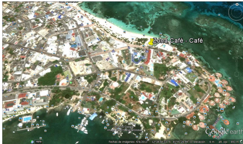
Foto 11-17. Zona de rebose del Alcantarillado Sanitario, Café – Café.
