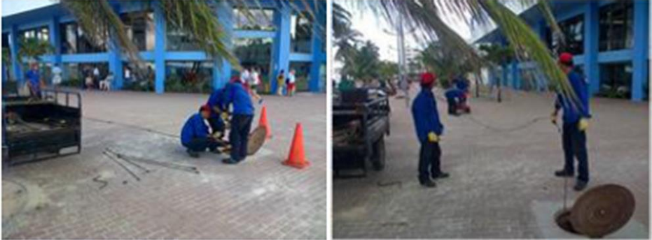
Foto 9-28 Mantenimiento con Rotosonda sector peatonal.
