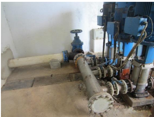
Múltiple de succión en 6" – Succión de la bomba 3"
