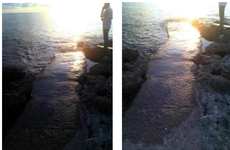
Foto 9-42 Llegada impulsión del emisario submarino al mar
