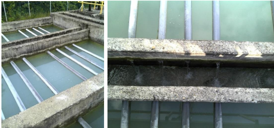
Foto 7-10 Unidad de sedimentación, canal de agua sedimentada.
