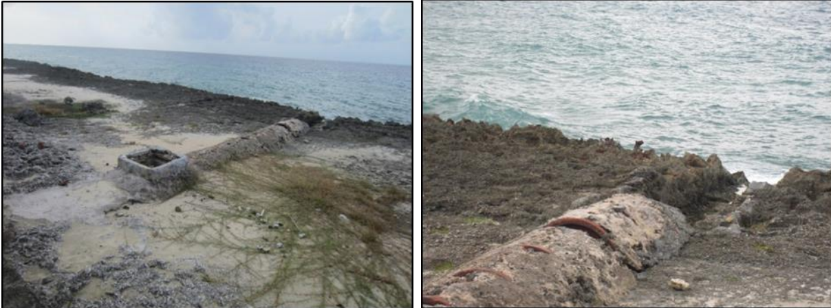
Foto 9-44 Tubería de descarga al mar
