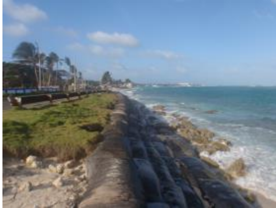
Figura 53. Muros en bolsacreto localizados en Sur este (archivo personal Liane Gamboa).
