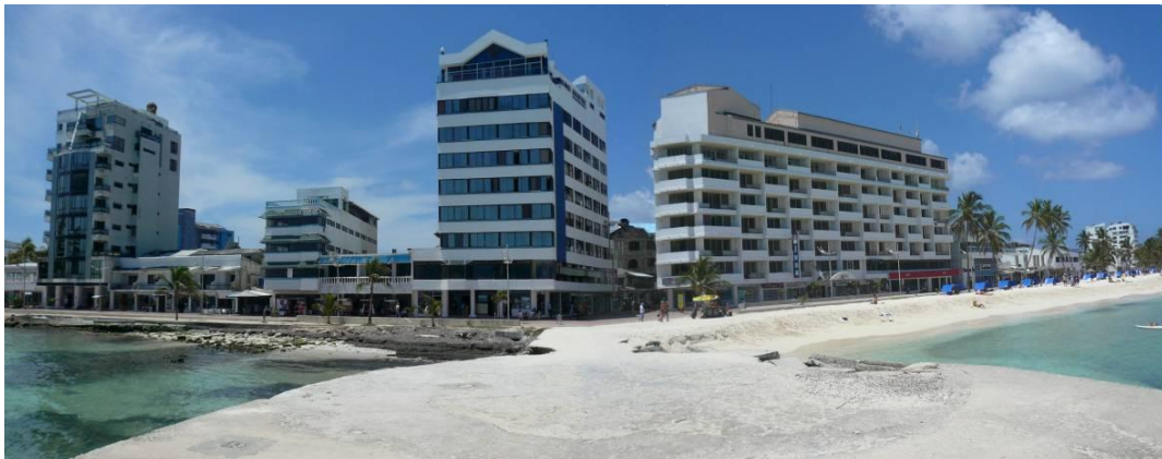
Figura 43. Acumulación de sedimento a barlovento y erosión a sotavento del espón Tiuna.
