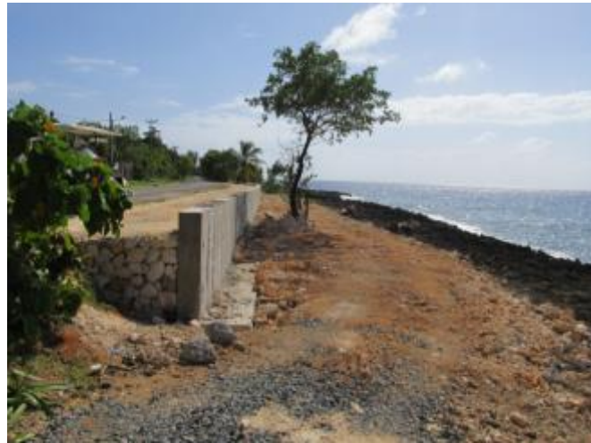
Figura 34. Intervención en la bancada vía circunvalar (archivo personal Liane Gamboa).
