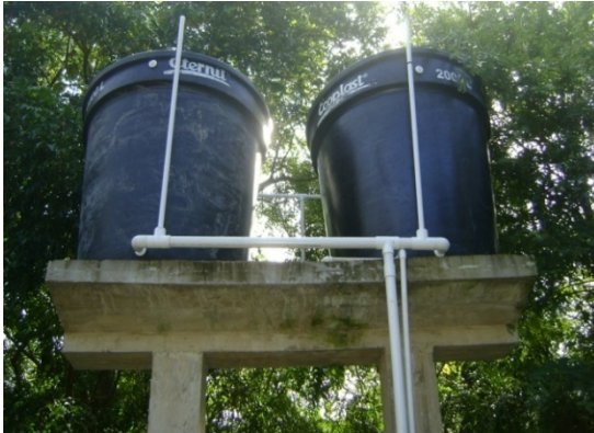
Sistema comunitario para la captación, almacenamiento y distribución de agua lluvia en la localidad de Schooner Bight, en la isla de San Andrés
