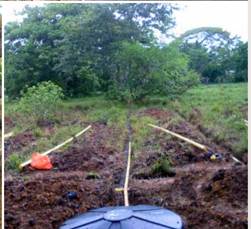
Foto 15. Sistema descentralizado de manejo de aguas residuales Sally Taylor en San Andrés (Fotos: Archivo CORALINA).
