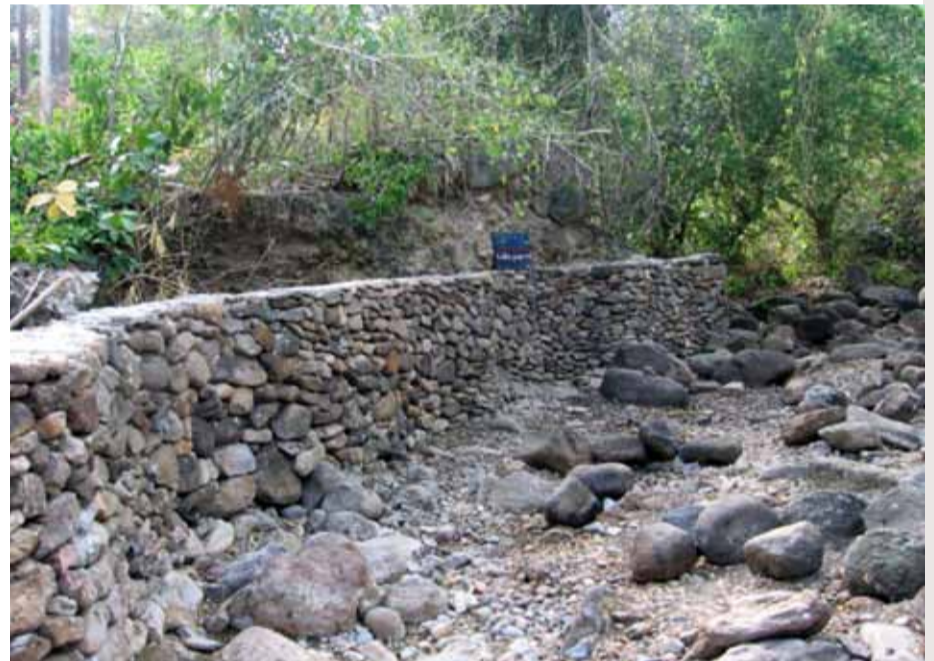
Foto 7. Control de erosión Gamadith Amareth en Providencia (Fotos: Martha Prada, CORALINA).
